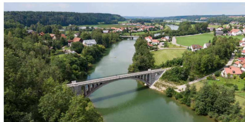
Illerbrücke, Illerbeuren © Eva Bartussek
