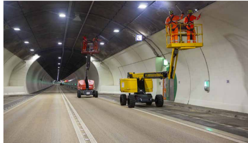
Hauptuntersuchung Grenztunnel Füssen © Eva Bartussek
